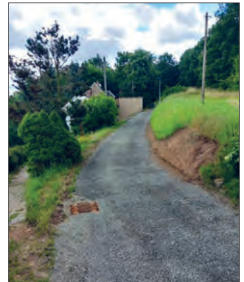
Herstellung der Entwässerung
