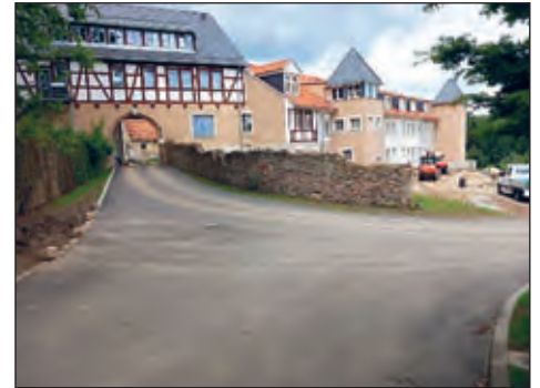
grundhafter Ausbau zur neu entstehenden Wohnanlage am Rittergut
