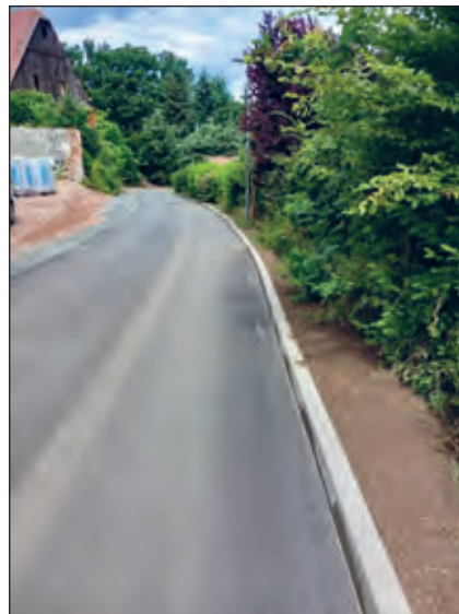
Einfassung der Zuwegung mit Borden
